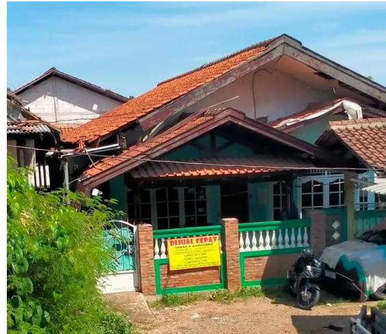
Jl. Utan Jaya RT/RW 002/004, Pondok Jata, Cipayung, Depok Luas: 189m 2 Harga Rp 450.000.000,00
